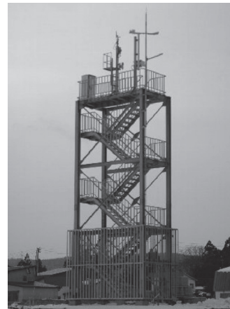
写真一九 気象観測タワー（金浜消雪基地）
