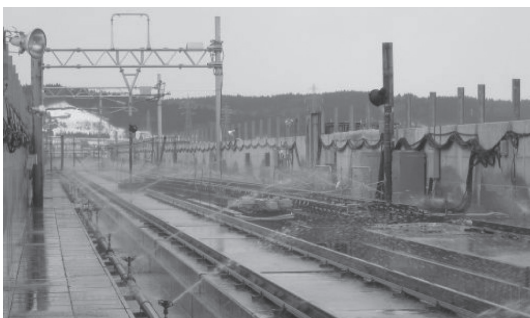
写真一 4 散水試験中の船岡消雪試験場
