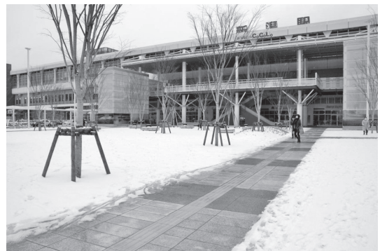
写真一5 地中熱ヒートパイプ方式の融雪状況
