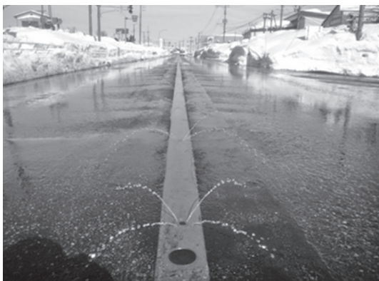
写真一 散水消雪施設の消雪状況
