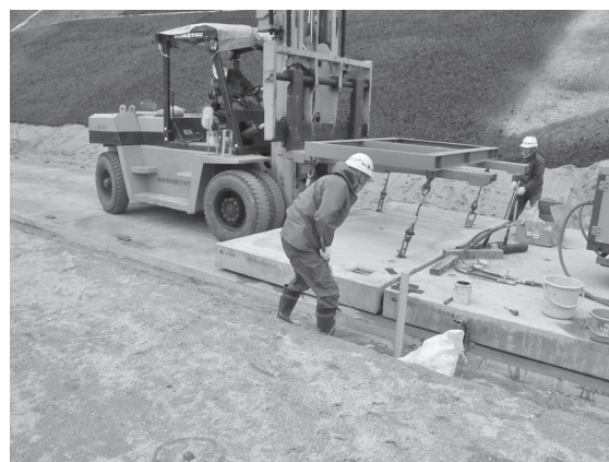
図-11 リフトによる運搬・据付作業状況
