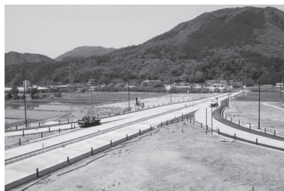
図-12 無散水融雪パネルの据付完了時の状況
