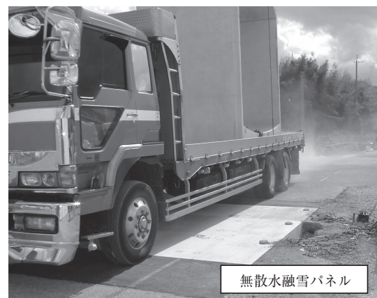
図一 5 車両走行によるせん断キーの効果確認実験状況
