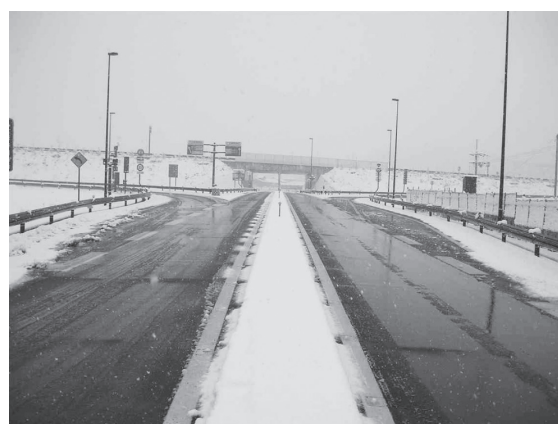
図-13 山東ICにおける無散水融雪パネルの融雪状況
