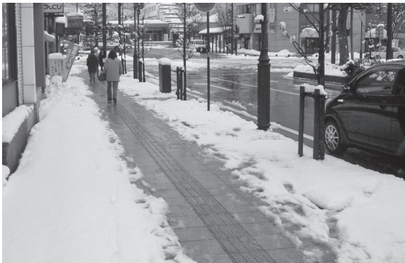
図一 3 セット融雪工法の融雪状況
