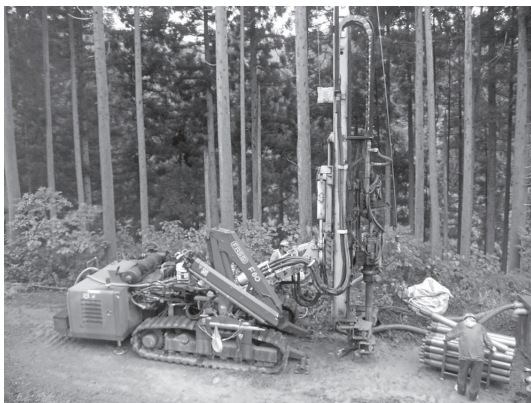
写真—1 ボーリングマシン (150 kW 級)
