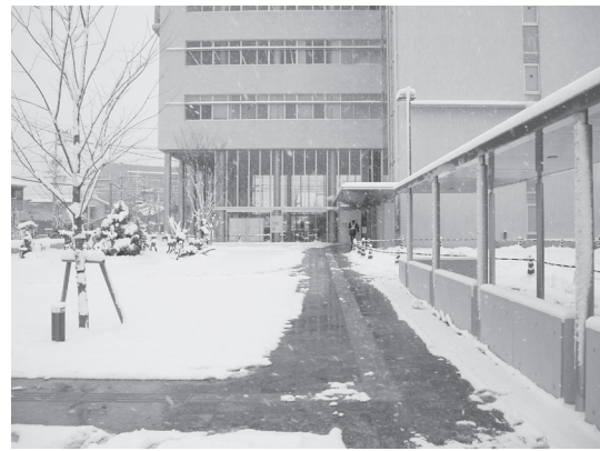
写真一六 融雪状況（歩道部）
