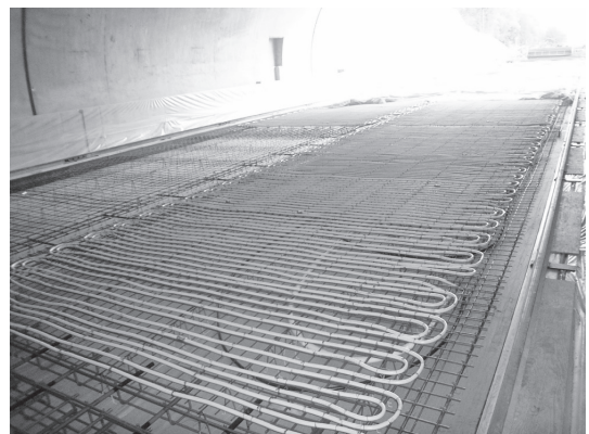
写真—3 放熱管敷設状況
