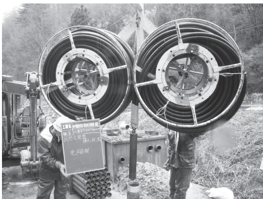
写真—2 ポリエチレン管挿入状況
