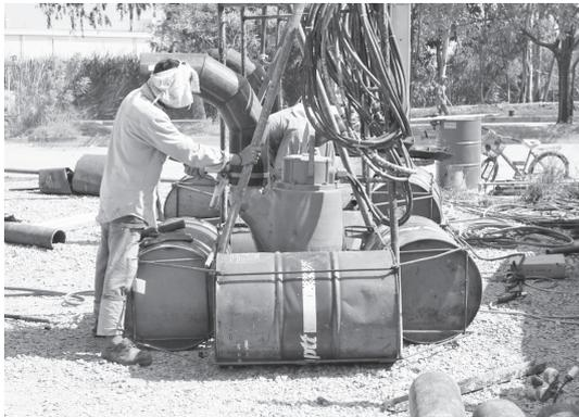
写真—8 ドラム缶をフロートにしたポンプ
