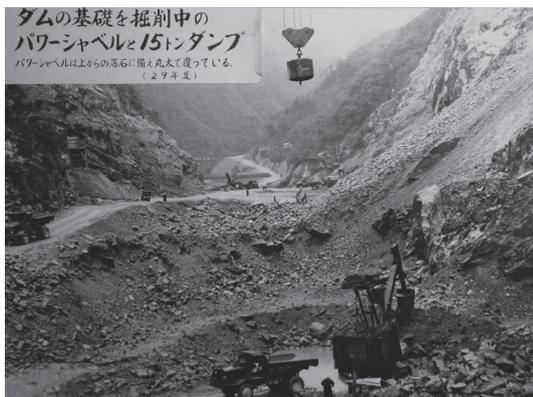
写真一六 掘削工事状況
