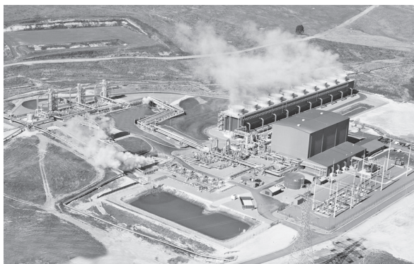
写真—1 発電所全景
