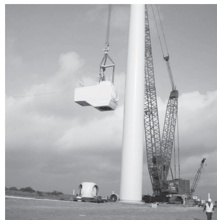
写真一九 現地でのナセル一体吊上げ
