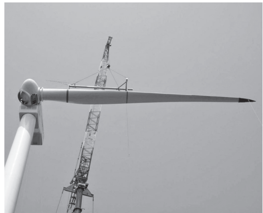
写真一七 翼一本付け工法
