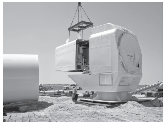
写真一八 現地でのナセル一体組み
