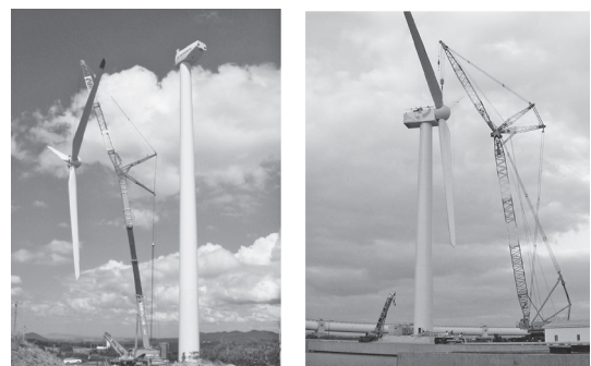
写真—4 油圧クレーン（左）とクロラクレーン（右）
