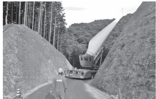
写真—3 ブレード（翼）起立装置
