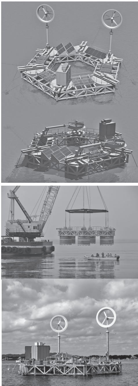
図一 博多湾プロジェクト(ステージI) 2011 18 m 直径浮体, 3 kW レンズ風車 2 基, 1.5 kW 太陽光パネル, 計 7.5 kW エネルギーファーム
