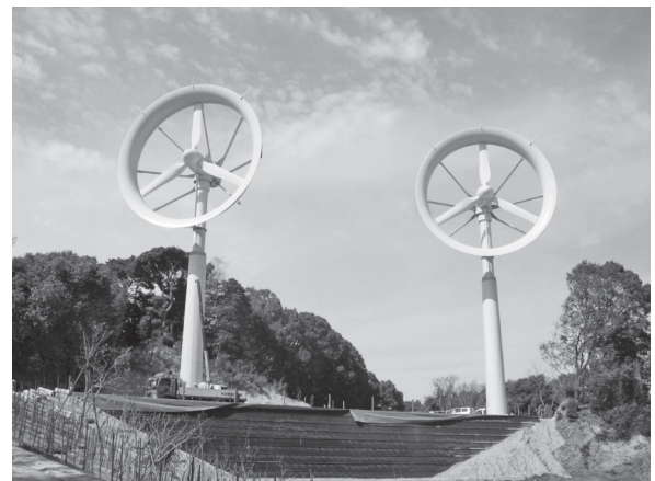
図一6 100kW レンズ風車（定格風速12m/s，九大伊都キャンパス）
