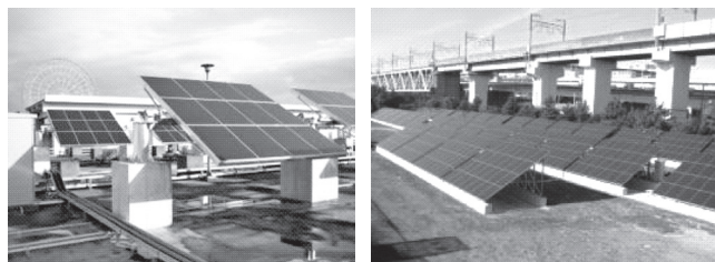
写真-1 (左) 追尾型及び(右) 固定型の太陽光発電設備外観
