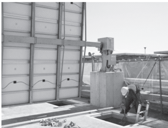
写真一2 追尾型の近傍での工事の様子
