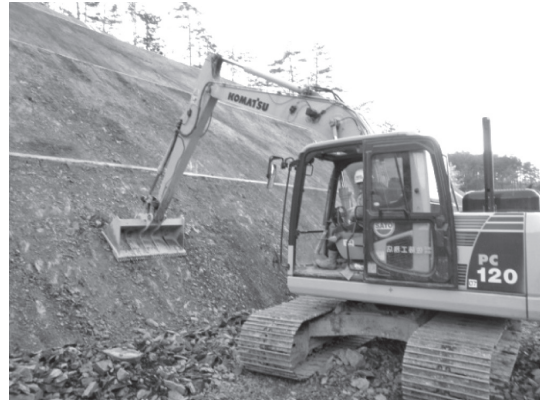
写真—6 改良されたパワーショベルの活用
