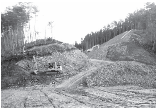
写真一七 起伏のある施工現場
