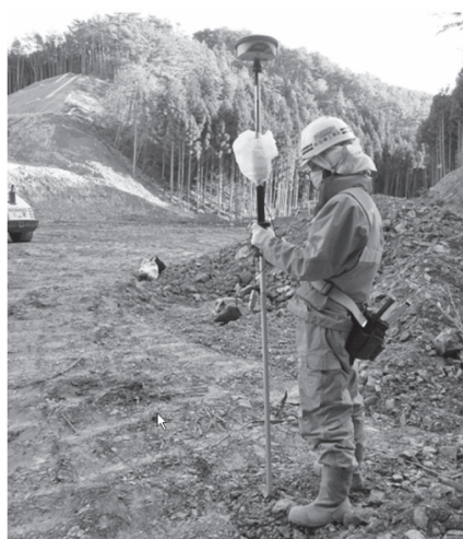
写真—1 作業形状確認状況
