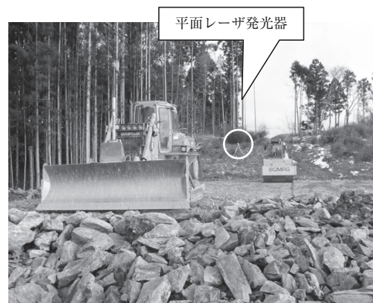
写真—4 作業状況
