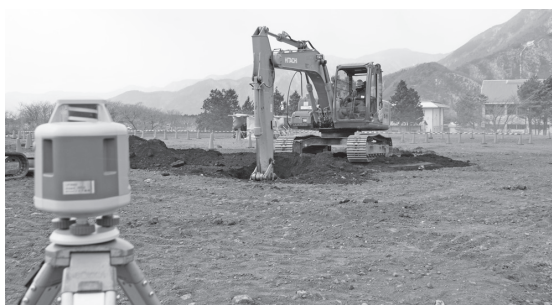
写真—1 回転レーザーと受光器による情報化施工の実習
