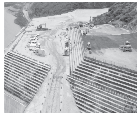
写真一11 CSG 盛土 施工状況
