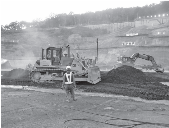
写真一8 3D-MC ブルドーザ施工状況
