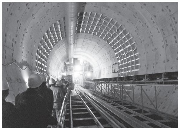
写真一 3 上層シールドトンネル（掘削中）
