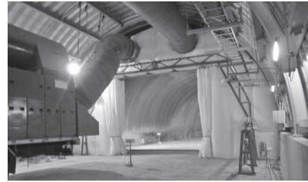
写真一 トラベルクリーンカーテン設置状況
