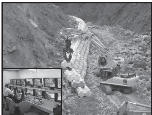
図1 無人化施工によりブロック積みを実施した事例
