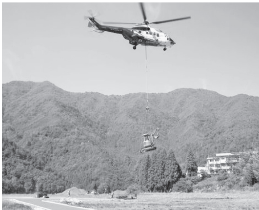
写真—14 ヘリによる小型重機の運搬状況
