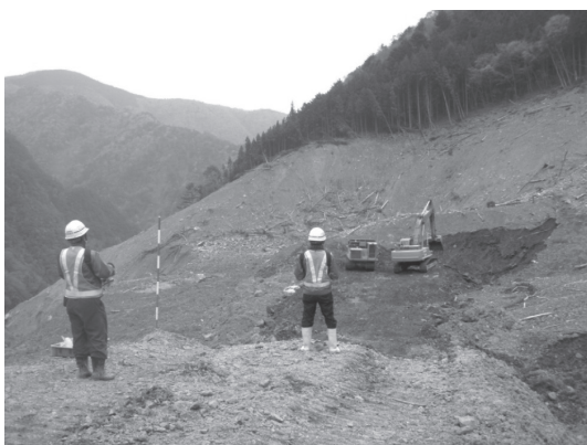
写真—15 無人化施工の実施状況
