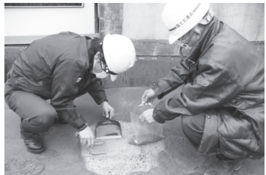
写真一 4 降灰等の堆積状況の調査
