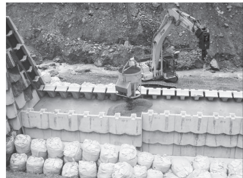
写真一一 ②コンクリート工
