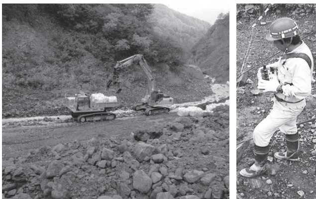
写真一九 大型土のう運搬・据付
