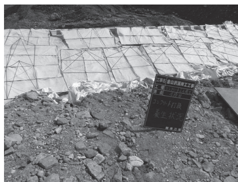
写真-7 (3) 養生ユニット
