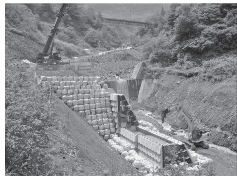
写真二 無人化施工状況
