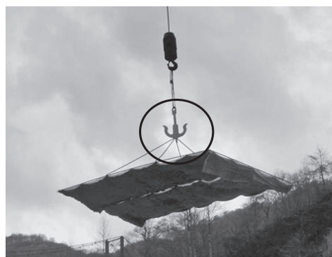
写真-6 (3) 簡易吊り上げフック
