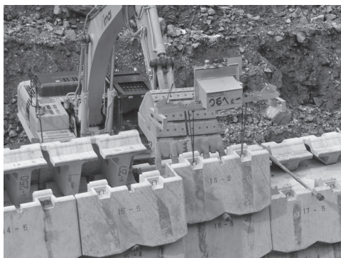
写真-4 (1) 鎧ブロック吊り具
