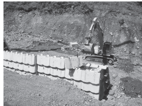
写真一〇 ①ブロック据付作業
