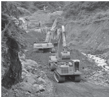
写真一八 無人掘削・積込・運搬
