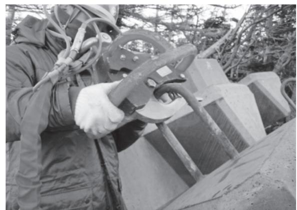
写真一2 吊り金具に電磁フックを掛ける状況
