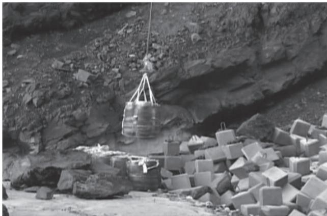
写真—3 大型土のうをヘリコプター施工している状況
