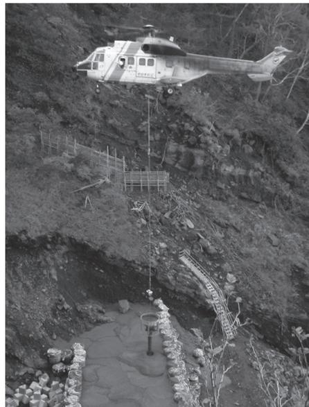
写真—4 高流動コンクリートをバケット打設している状況
