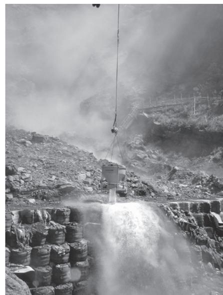
写真—5 打設面を流水で清掃している状況
