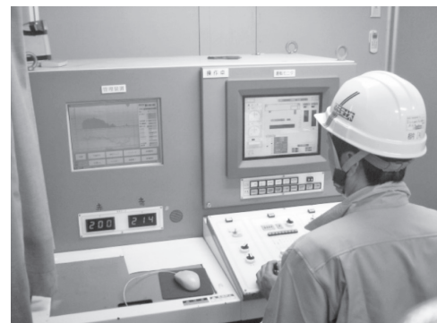
写真二 操作卓による均し機運転状況
