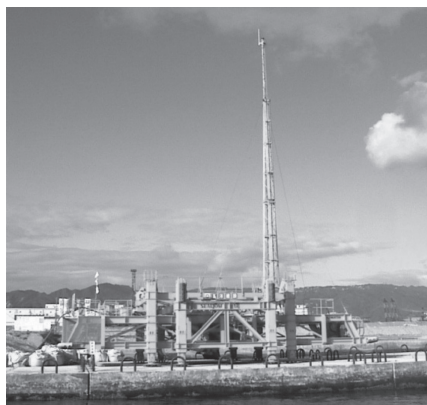
写真一 均し機全景
