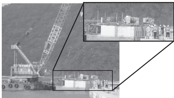
写真—3 据付状況 (全体)
