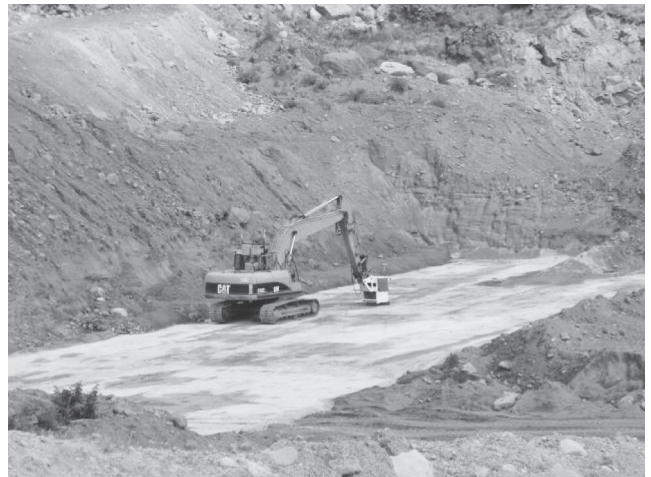
写真一七 施工状況
