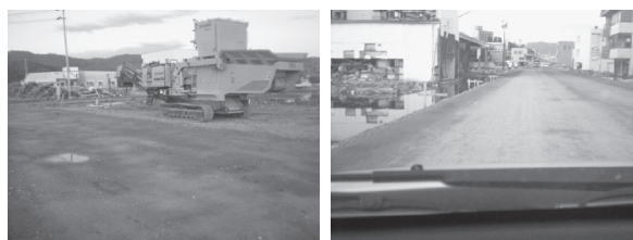
瓦礫使用路盤試験施工
