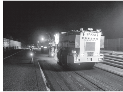
切削工事(舗装業)
