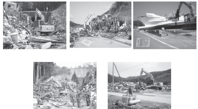
図一 19 支援状況 (瓦礫撤去)
