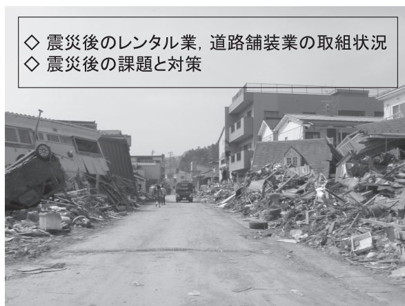
図一22 道路啓開の状況
