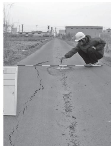
写真一六 液状化対策施工（被害有り）
