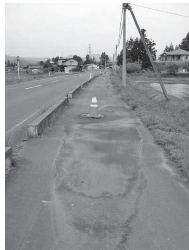
写真一3 液状化対策施工箇所（被害軽微）
