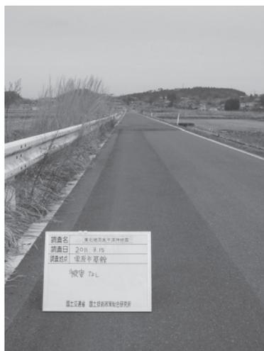
写真一五 液状化対策施工（被害なし）
