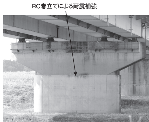
(b) 耐震補強されていた橋脚の状況
