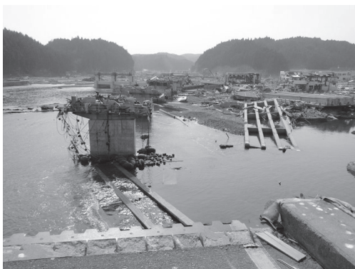
(a) 上下裏返しになったポストテンPC桁
