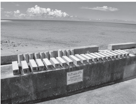
写真一八 曝露試験状況
