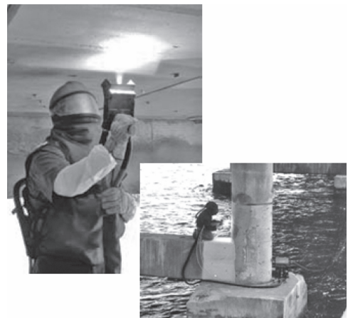
写真一五 亜鉛溶射の施工状況
