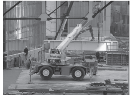
写真-5 La Défense 地区の建設工事現場で稼働中のクレーン車
