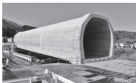
写真-1 RC スノーシェルター
