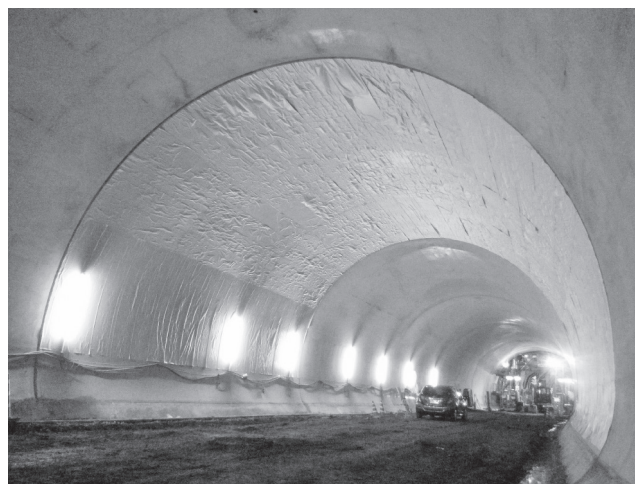
写真—1 キュアリングシール工法施工状況
