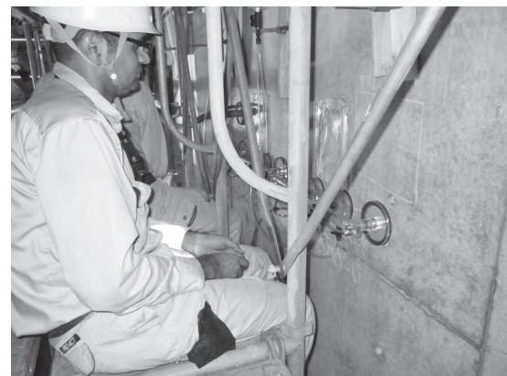
写真-2 測定状況
