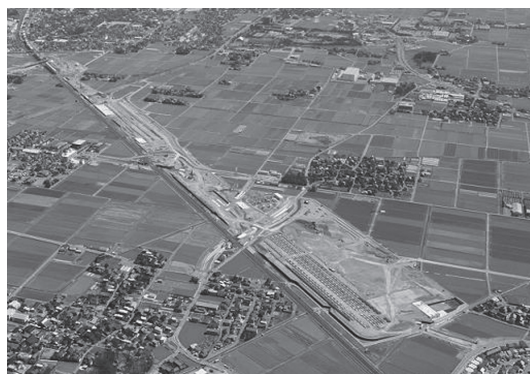
写真—1 現場全景
