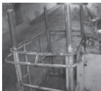
図—3 バケット四隅に鋼管を取り付ける
