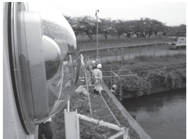
写真—4 本遠隔監視 Web 動画カメラで現地の様子を確認
