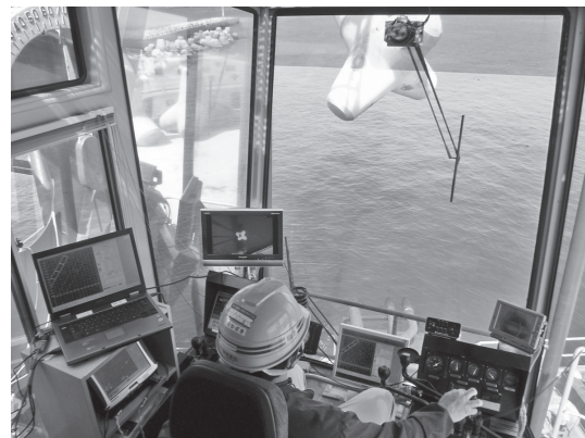
写真一2 クレーン操作状況
