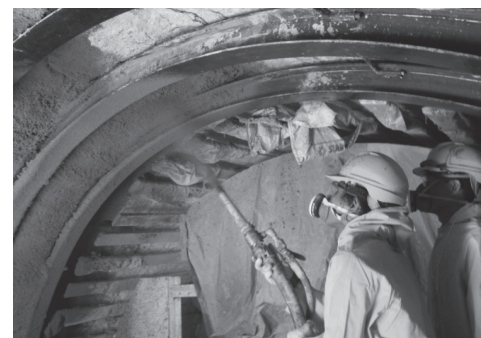
写真—17 TBM 鋼製支保工設置, ファイバーモルタル吹付け状況
