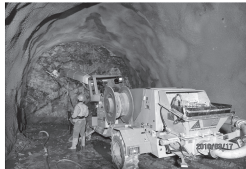
写真—11 吹付け状況
