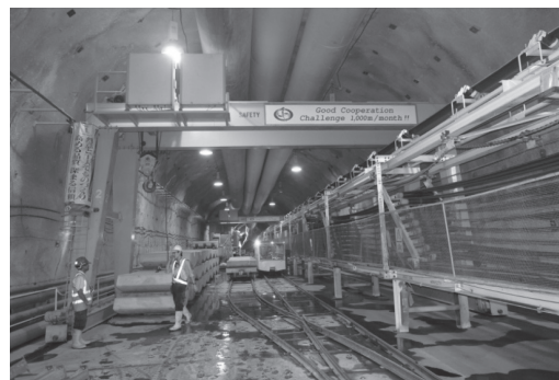
写真-2 TBM 発進基地
