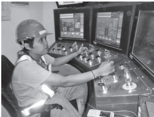
写真—18 TBM モニタリングシステム
