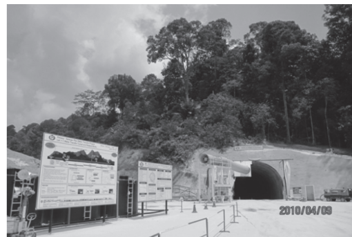
写真-1 作業トンネル坑口看板
