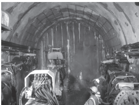
写真—9 NATM-3 河川横断長尺先受け工法施工状況
