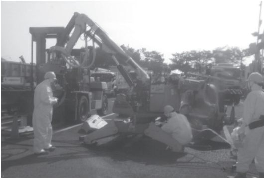
写真一4 BROKK330Dの除染作業
