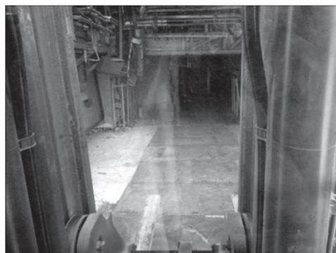
写真一七 鉄板敷設作業時の運転席から見た前方視界（出典：東京電力ホームページ）
