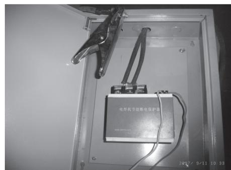
写真—6 交流アーク溶接機用自動電撃防止装置
