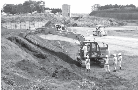
写真-1 MG 油圧ショベルの実習状況
