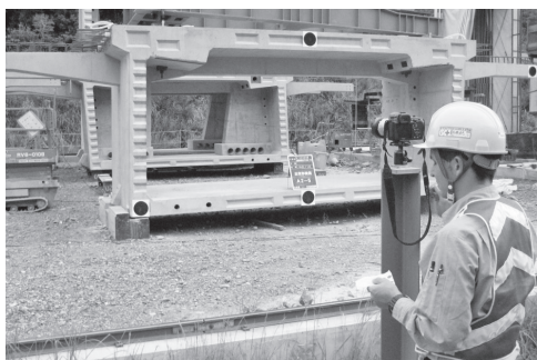
写真—1 セグメントの計測状況
