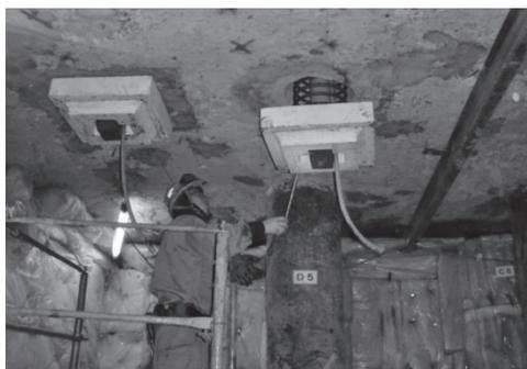
写真-4 新設アンカーボルト挿入状況
