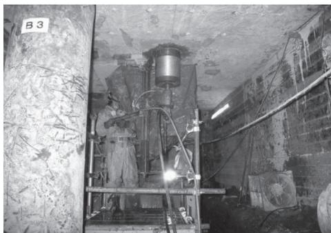
写真-3 アンカーボルト撤去状況
