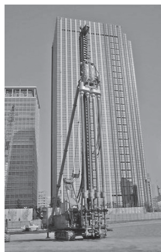
写真一 深層混合処理機（4軸機）
