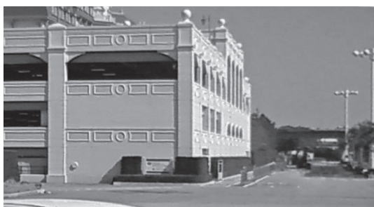
写真—5 対象建物の地震直後の状況
