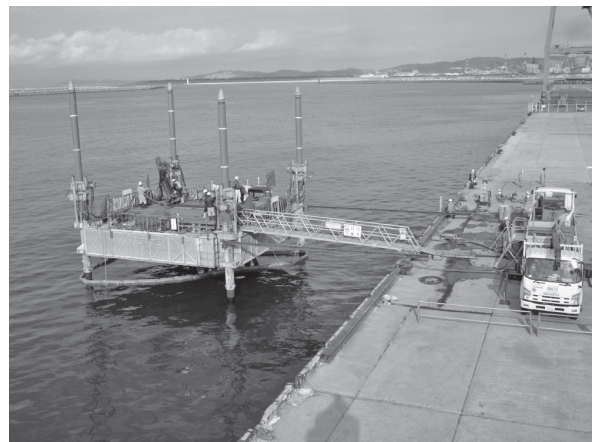
写真-3 (a) 施工状況 (海側)
