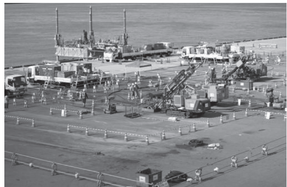
写真-3 (b) 施工状況 (陸側)
