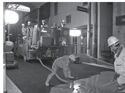
写真—3 商店街現場施工状況
