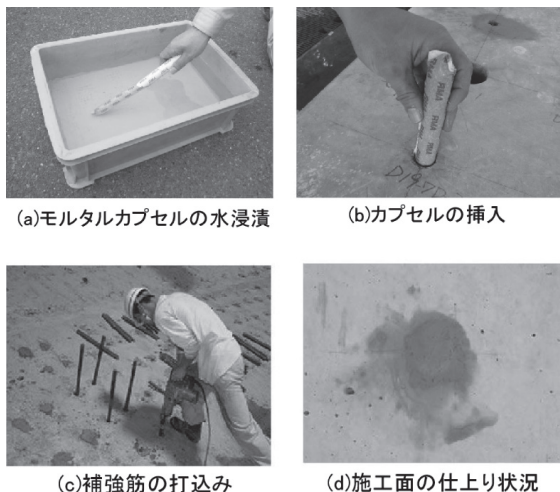
写真-1 本工法の施工状況の例の比較
