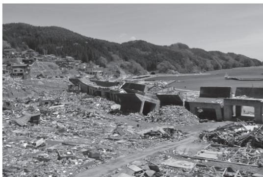
写真一 津波により倒壊した防潮堤
