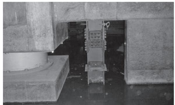
写真一4 仮設支柱・仮設壁による拘束状況
