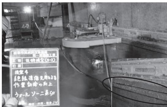
写真-6 ウォールソー2条切り仮設壁切断状況 (右下囲みは切断部近景)
