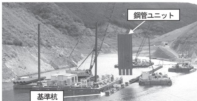
写真一7 仮締切施工状況
