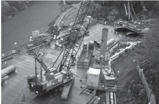
写真—12 全周回転式オールケーシング施工状況
