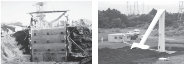
③鉄筋補強土工の効果確認試験 ④風力発電タワー強度試験
