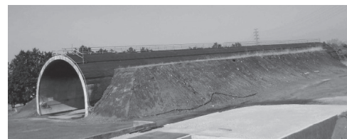
写真—9 模擬トンネルの全景
