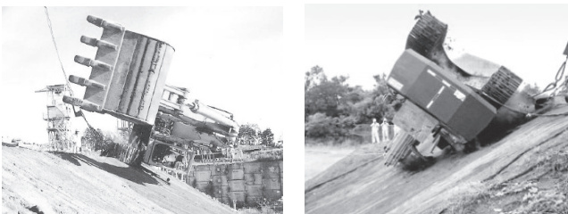
写真-11 油圧ショベルの転倒実験状況
