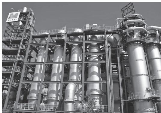
写真-4 空気予熱器と燃焼室（左：炭化物 右：ガス）
