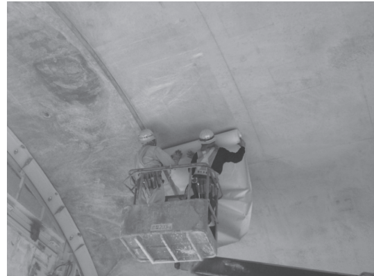
写真—2 施工状況
