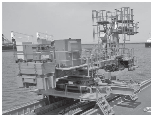
写真—3 パイルキーパー装置部
