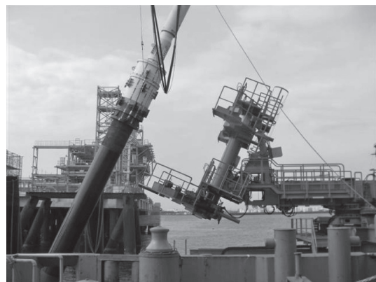
写真-5 油圧ハンマ打設状況
