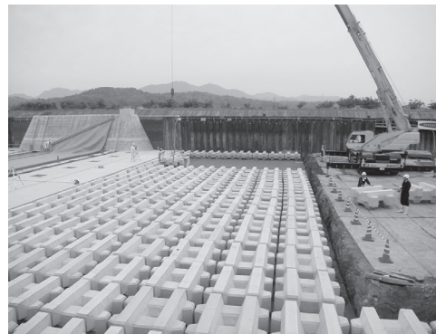
写真—11 護床ブロック据付
