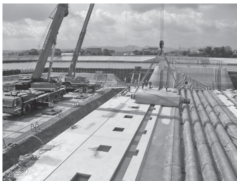
写真-12 ゴム引布袋体の取付
