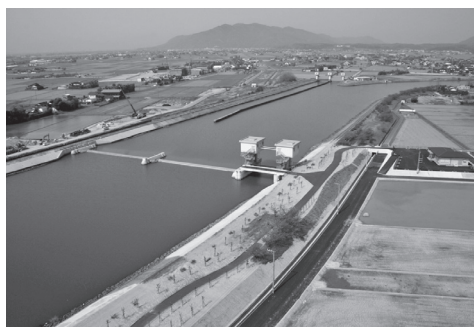
写真—1 完了全景
