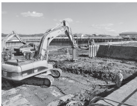
写真一7 地盤改良状況
