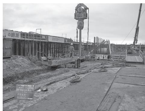
写真—6 遮水鋼矢板打設
