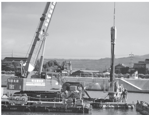
写真—4 鋼矢板打設（オーガ併用圧入工法）
