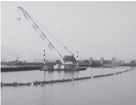
写真—15 汚濁防止フェンス
