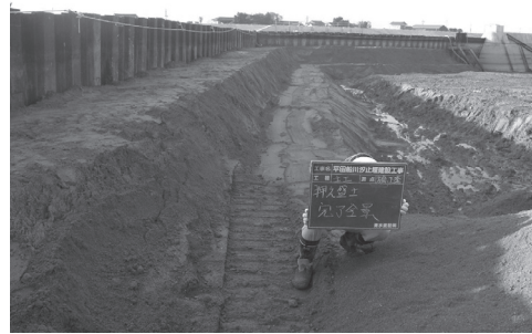
写真—5 押さえ盛土
