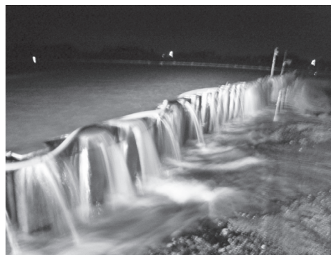
写真-13 越流状況
