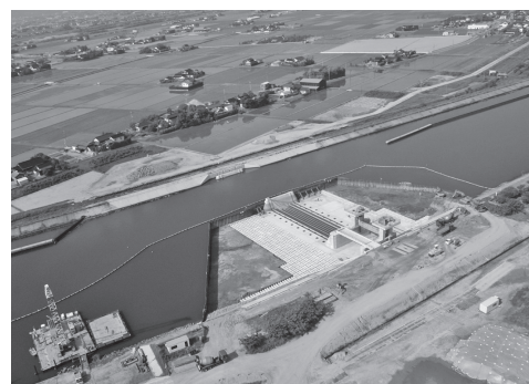
写真-3 2期(左岸側) 工事施工状況
