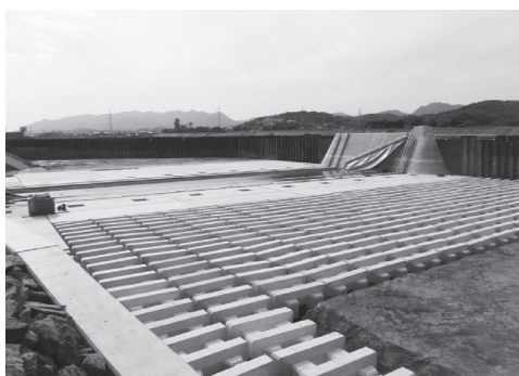
写真-2 1期(右岸側) 工事施工完了
